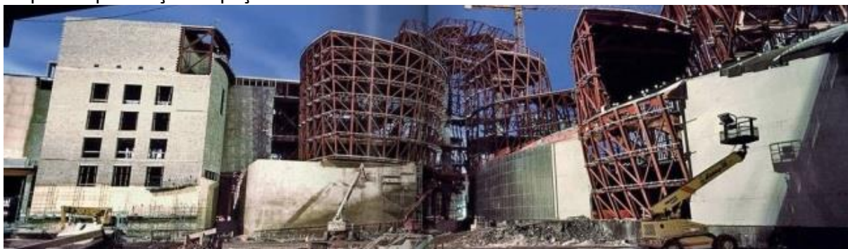
Figura 4: sistema estrutural da edificação do museu.
